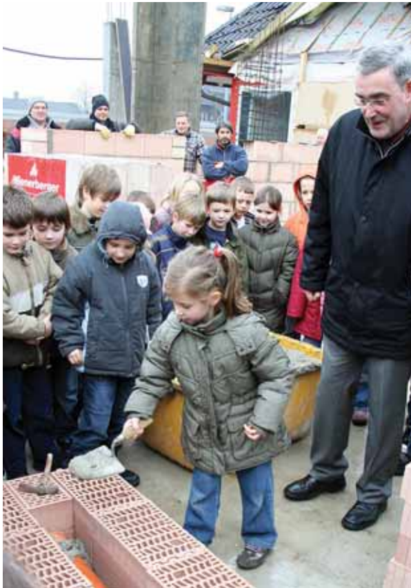
Ein etwas anderes Geburtstagsgeschenk erhielt die siebenjährige Mila. Die Schülerin der St. Georg-Grundschule Nütterden durfte zur Feier ihres Jubeltages zur Kelle greifen und bei der Grundsteinlegung des Erweiterungsbaus der Schule mithelfen. Im Beisein von Bürgermeister Günter Steins erhielt das Mädchen noch Unterstützung von seinem Mitschüler Nicolas (links daneben in freudiger Erwartung), der ebenfalls Geburtstag hatte. Mehr über die Grundsteinlegung im Innenteil. NN-Foto: CS
